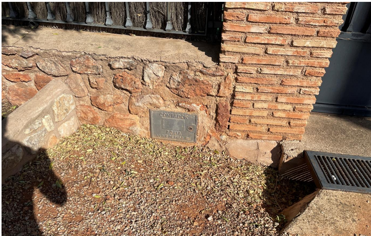
Acometidas a la red de abastecimiento de agua potable existente en los Sectores 14 y 15.
