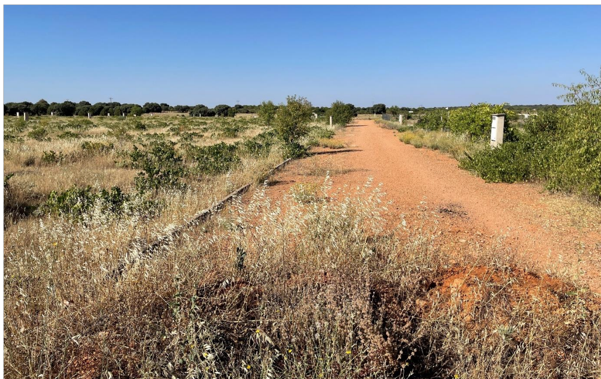
G.8 – Sector 15. Inicio de parcelación (encintado bordillo y armarios eléctricos)
